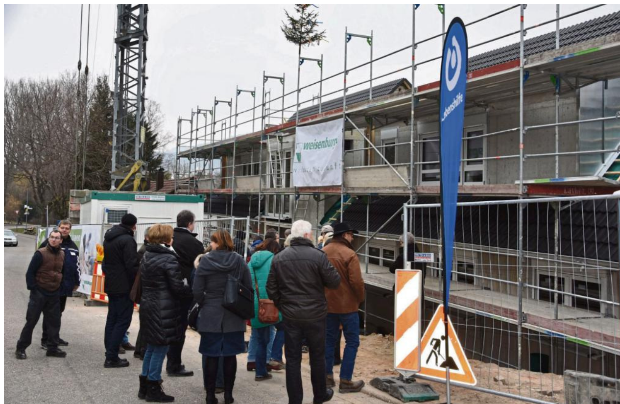
IM SPÄTSOMMER soll das neue Wohnhaus der Lebenshilfe in der Weinauerstraße 12 bezugsfertig sein. Konzipiert wurde es für zwei Dreier-Wohngemeinschaften und fünf Einzelpersonen. Foto: Dürr
